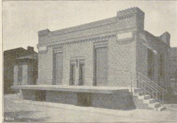
Fig. 68. Laderampe am Akkumulatorengebäude.
