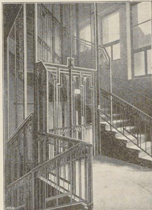
Fig. 75. Fahrstuhl in den Treppenhäusern der Laboratoriengebäude.
