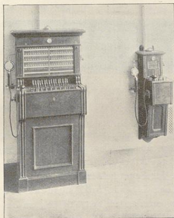
Fig. 188. Umschalterschrank für die Hausanschlüsse und Umschalterschrank für die Postanschlüsse der Fernsprechanlage. (No. 6 und 7 der Figur 185.)
