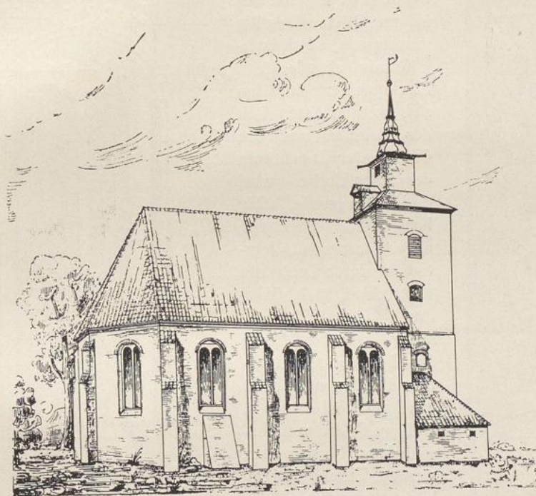
Fig. 50. Kirche in Stellichte; Nordseite.
