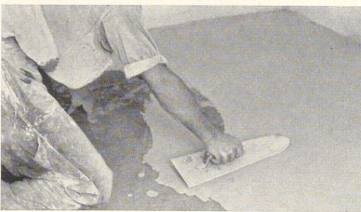
Bild 270. Auftragen und Glätten der reinen Estrichgipsschicht
