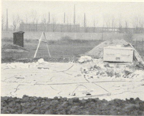
Bild 11. Gefüllte Kalkgrube auf der Baustelle. Der eiserne Kasten dient zum Ablöschen des Kalkes und wird später zur Mörtelbereitung verwendet
