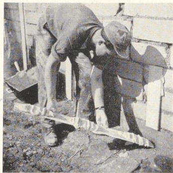
Bild 55. Aufkleben der Unterlagstreifen auf das Mauerwerk
