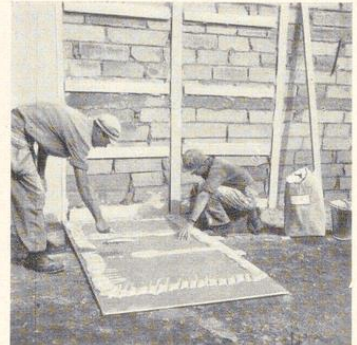
Bild 57. Auftragen von Leimfix
