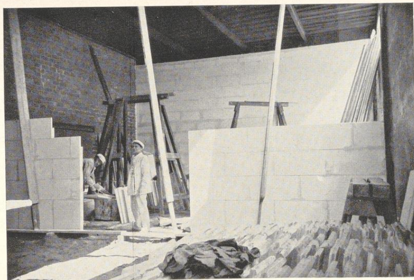
Bild 71. Frisalit-Gips-Bauplatten-Wand, noch unverputzt
