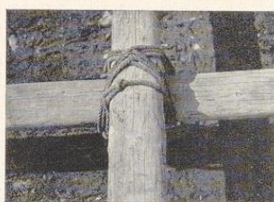
Bild 141. Binden nebeneinanderliegender, sich kreuzender Stangen mittels Kreuzbund
