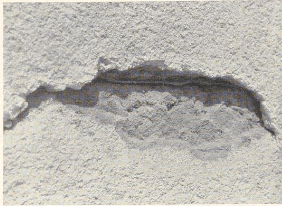
Bild 300. Gequollener Parkettboden hat das Mauerwerk nach außen geschoben und damit auch den Außenputz abgedrückt
