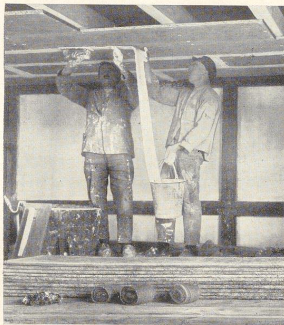
Bild 70. Deckenschalung mit Leichtbauplatten. Überkleben der Fugen mit Jutestreifen, die in Gipsbrei getaucht wurden (Alte Ausführung)
