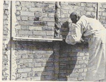
Bild 173. Herausziehen der Mörtelleiste
