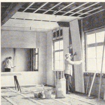
Bild 61. Ansetzen der Platte an der Wand
