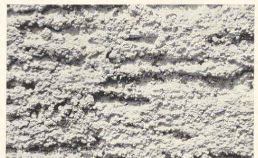
Bild 235. Münchner Rauputz aus grobkörnigem Material, waagrecht verschiebt
