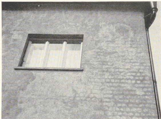
Bild 289. Durchschlagen der Fugen infolge zu schwachen Putzes
