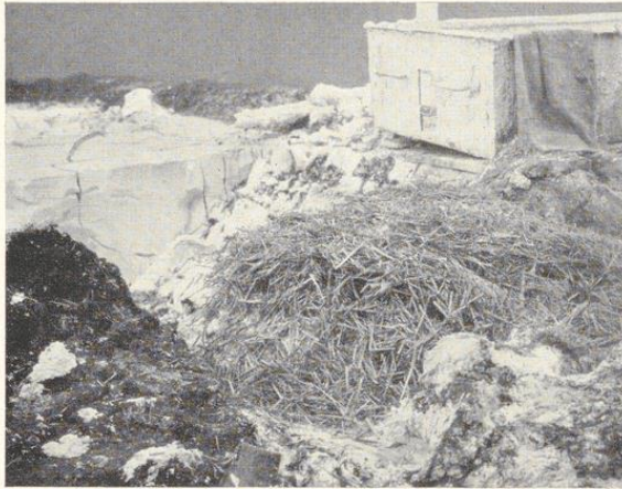
Bild 35. Bereitung des Strohalkmörtels in Düsseldorf. Zerhacktes Heu oder Stroh wird über den Kalk und Sand gestreut und dann mit der Schippe von Hand gemischt
