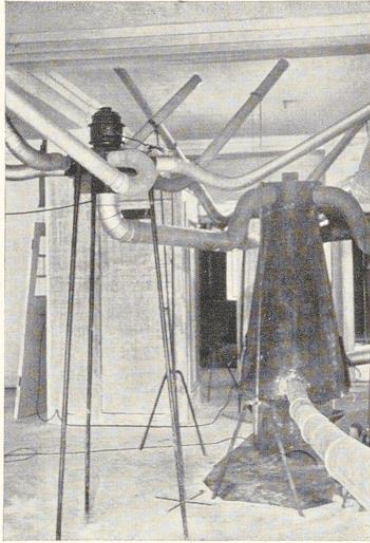
Bild 190. Föhngebläse-Bauaustrockner in der Anwendung, rechts der Heizofen mit Frischluftzuleitung, links das Gebläse mit den Gebläserohren. — Bild 191. Grundriß eines Einfamilienhauses mit den eingezeichneten Aufstellungsorten des Föhngebläses
