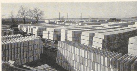
Bild 73. Lager von Frisalit-Gips-Bauplatten
