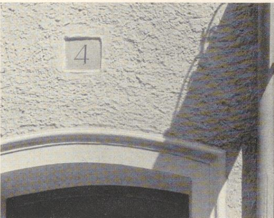
Bild 212. Einfacher Kalkputz mit der Kelle angeworfen und geweißt. Türeinfassung in Kalkmörtel gezogen. Haus in Weilheim (Oberbayern)
