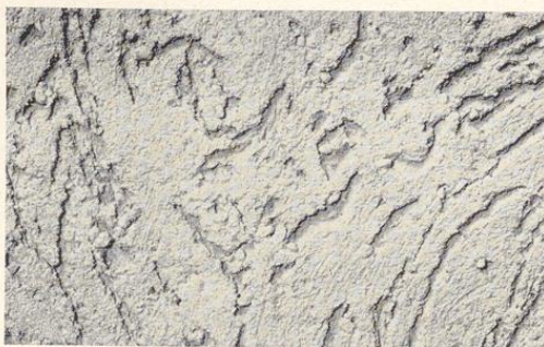
Bild 234. Münchner Rauputz, aus grobkörnigem Material, Auftragstärke 10 mm
