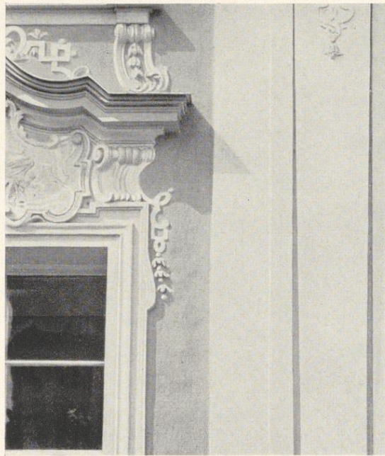
Bild 217. Glattputz am Lamberg-Palais in Passau. Staatl. Dombauhütte, Passau
