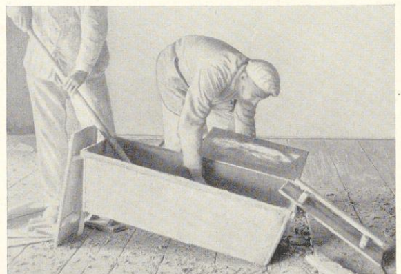
Bild 185. Arbeitsweise in der Pfalz. Der Anmachkasten, ohne Füße, steht direkt auf dem Gerüst
