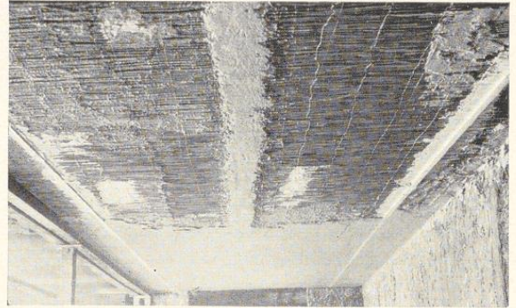
Bild 179. Herausziehen der Mörtelleiste zwischen den Gipsleisten
