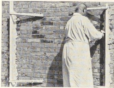
Bild 172. Abstreichen des Mörtels an der Gipsleiste
