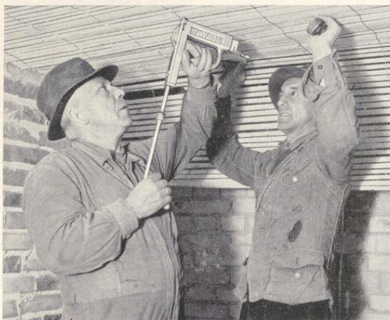
Bild 102. Befestigung von Holzstabgewebe mit dem Bukama-Rohrhefter
