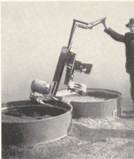
Bild 95. Zyklo-Mörtelmischer. Umstellen des Rührwerks
