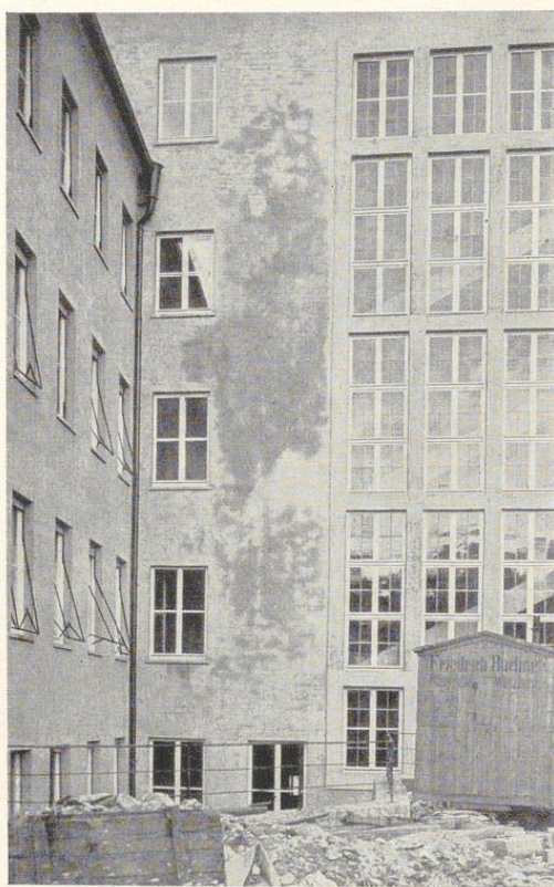
Bild 291. Durch Einwirkung von Frost entstandene Fleckenbildungen in Edelputz
