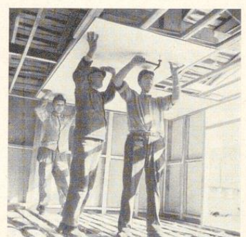
Bild 60. Aufnageln der Platte an der Decke
