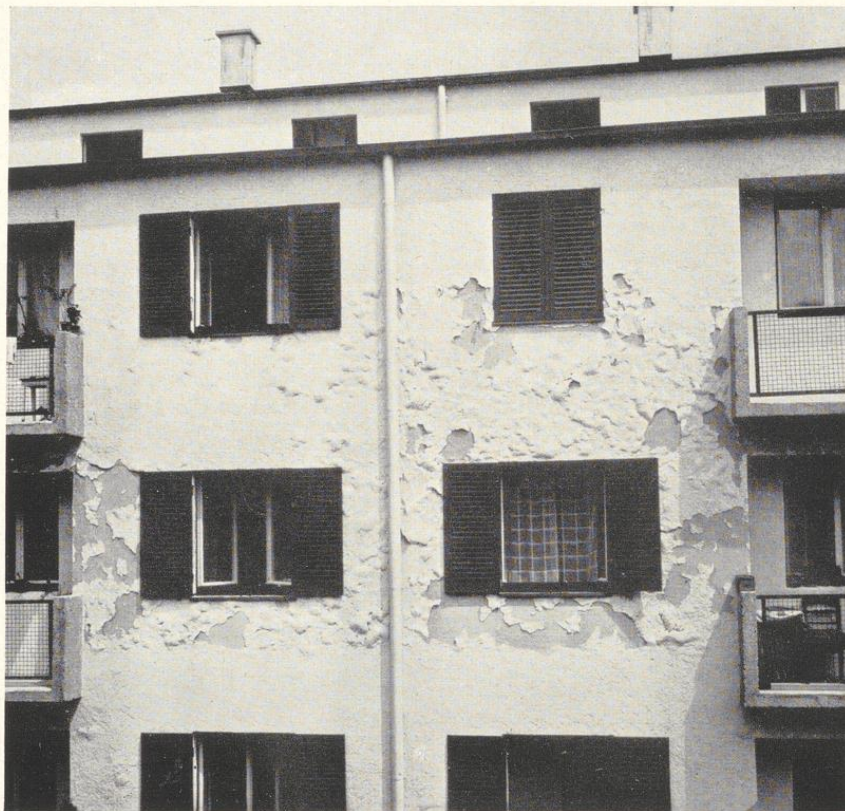
Bild 271. Blasenbildung im Oberputz infolge Verwendung zu frischen, nicht vollständig gelöschten Sackkalkes
