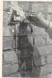
Bild 170. Anlegen des Gipspunktes
