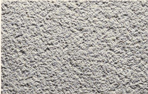
Bild 230. Feingestockter Edelputz. Auftragstärke 5 bis 8 mm
