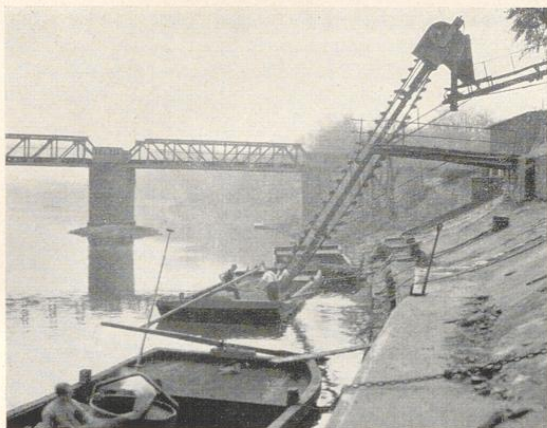
Bild 12. Fabrikmäßige Mörtelbereitung in Magdeburg. Der Sand wird in Kähnen angefahren
