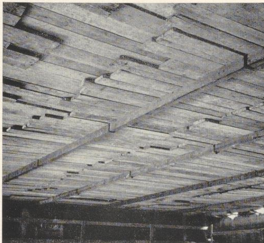
Bild 124. Hängende Innenrüstung ohne jede Stütze, aus Zürich
