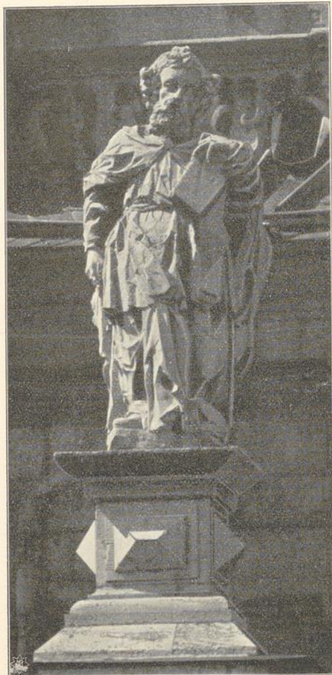
7. Apostelfigur von Strebepfeiler.
