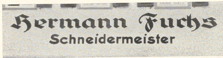
Bild 329. Vertiefte Putzschrift, ausgekratzt, der Schriftgrund gestrichen
