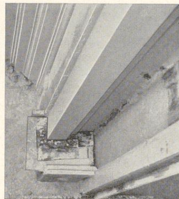
Bild 378. Anschlag am Unterzug mit Blindwand
