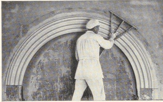
Bild 431. Halbkreiszug an der Wand mit der Radiuschablone
