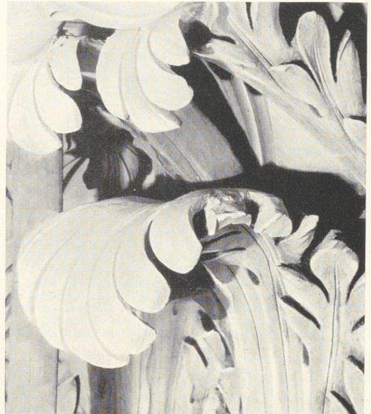
Bild 531. Akanthusblatt nach der Wiederherstellung in Stuck
