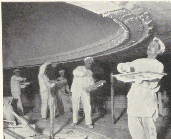
Bild 425. Das Auftragen des Materials für den Hochdruckzug
