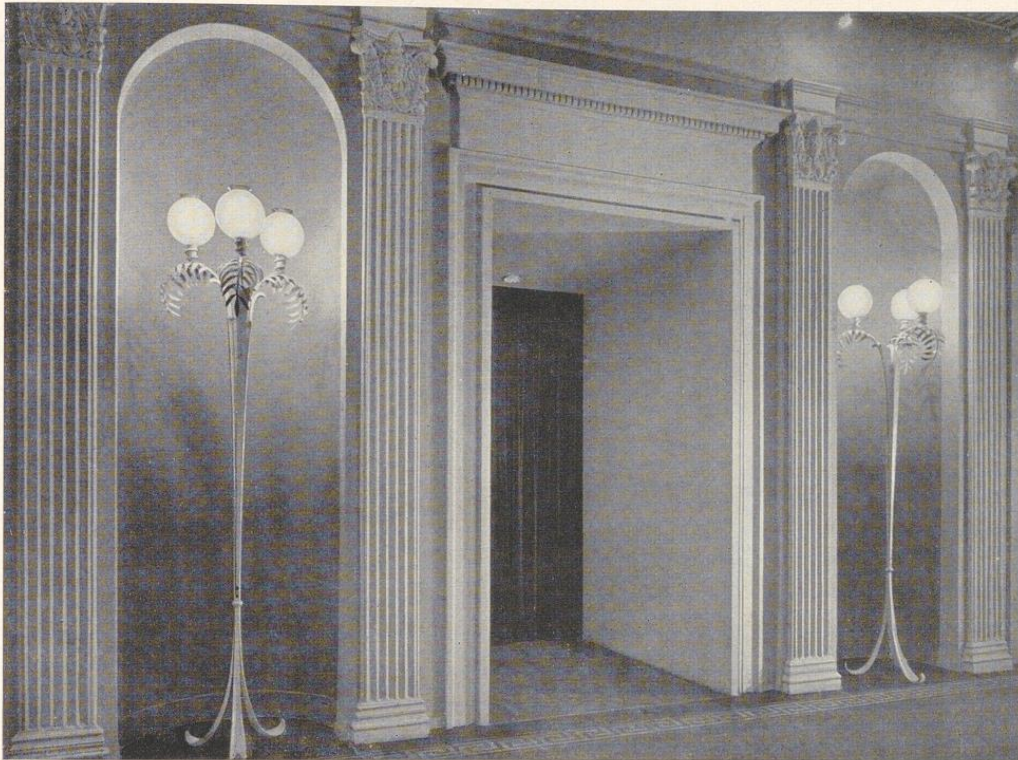
Bild 314. Wiederaufbau des Opernhauses in Hannover, Treppenhalle. Die erhalten gebliebene Stuckarchitektur wurde wieder ergänzt und instandgesetzt. Ausführung Hermann Klie, Hannover
