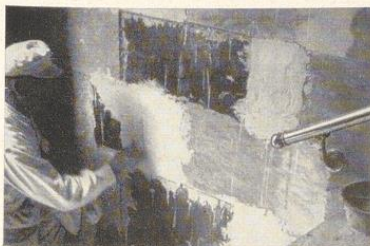
Bild 340. Antragen des Marmormörtels in Streifen
