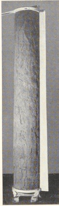
Bild 343. Mit Zement- haarmörtel grundier- te Säule
