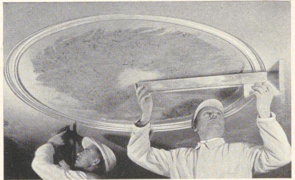
Bild 432. Kreiszug an der Decke mit der Radiuschablone
