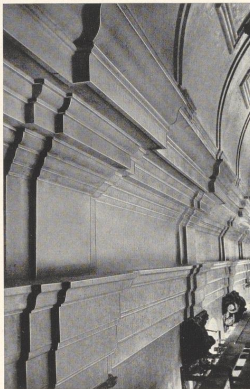
Bild 486. Freihändig zugeschnittene Verkröpfungen. Ausführung Wilhelm Denz, Neckarsulm
