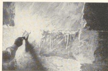
Bild 342. Spachteln der geschnittenen Marmorfläche
