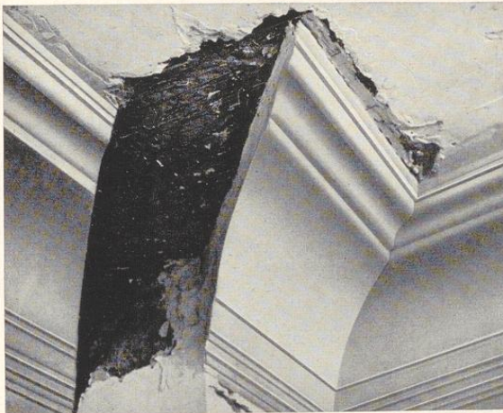
Bild 476. Einsetzen der Kropfstücke
