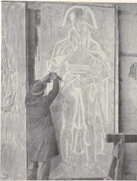
Bild 643–644. Die Maler Herbert Dimmel und Leopold Schmid führten in eigener Technik am österreichischen Heldendenkmal in Wien Reliefdarstellungen von Krieger in historischen Uniformen durch. Der Künstler schneidet (im linken Bild) das Relief naturgroß in Gips. Nach diesem Gipschnitt wird eine Positivform angefertigt und danach der Kunststeinguß hergestellt. Zum Schlusse wird das Steinrelief geschliffen. Wie das rechte Bild zeigt, wird die Oberfläche der Steingußplatte später durchgeschliffen, während die vertieften Teile den Gußton behalten und dadurch heller erscheinen
