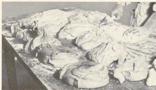
Bild 339. Haupttöne des Marmorstucks in einzelnen Kuchen vorbereitet
