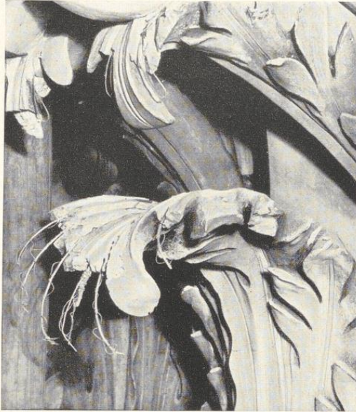
Bild 530. Beschädigtes Akanthusblatt im Dom zu Passau
