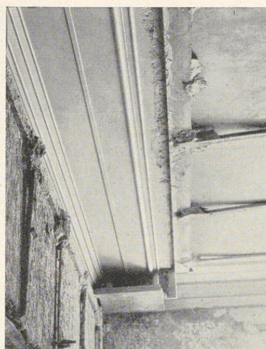
Bild 383. Anschlag für Eck- und Deckengesims
