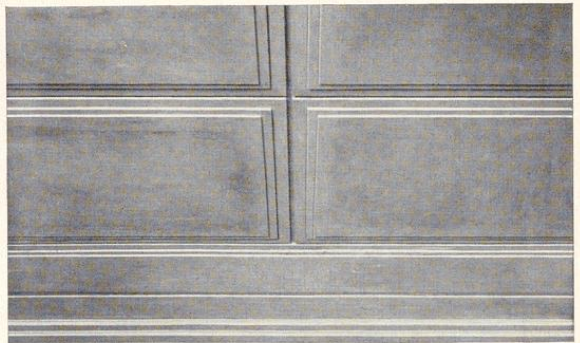
Bild 512. Kassettendecke mit fertigem Kreuzzug
