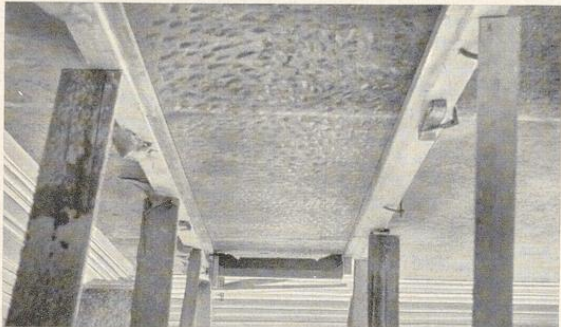
Bild 367. Abgesteifte Latten als Anschlag für den Deckenzug
