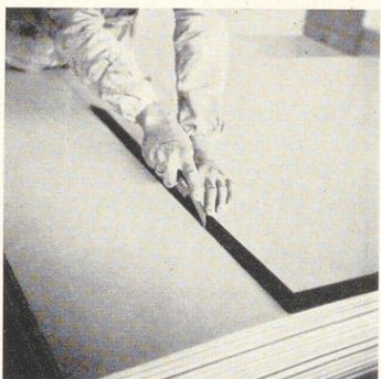
Bild 58. Durchschneiden des Kartons
