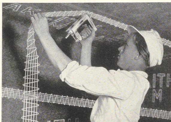
Bild 69. Befestigung der Drahtnetzstreifen über den Fugen der Leichtbauplatten (Neue Ausführung nach DIN 1102)
