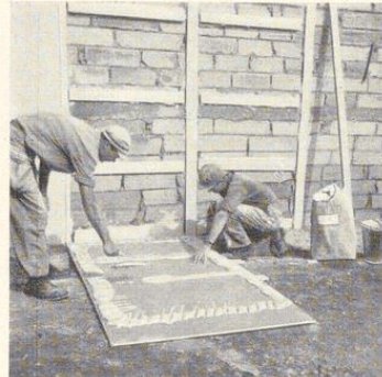
Bild 57. Auftragen von Leimfix
