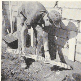
Bild 55. Aufkleben der Unterlagstreifen auf das Mauerwerk
