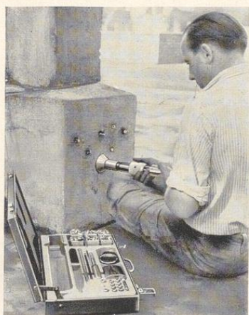
Bild 101. Einschießen der Bolzen mit dem Rapidhammer
