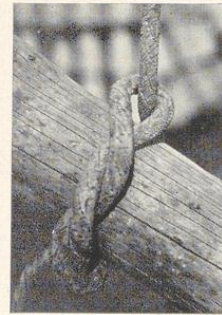
Bild 139. Der Latz zum Hochziehen der Stangen
