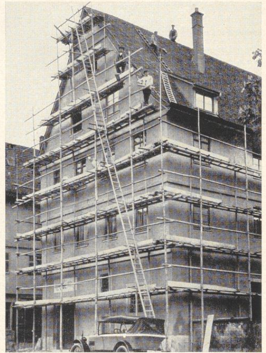
Bild 127. Leichtes Doppelstangengerüst ohne Verstrebung. Eckstangen direkt am Eck. Arbeitsweise in Württemberg
