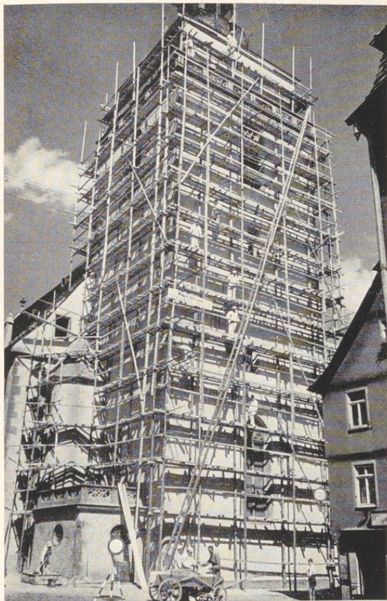
Bild 130. Leichtes Doppelstangengerüst mit außen liegendem Leitergang. Ausführung Gipsermeister Henne, Künzelsau. Württ.
