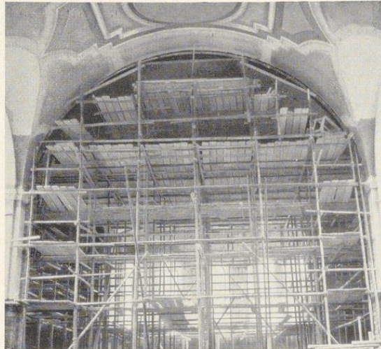
Bild 120. Hallengerüst aus Stangen, gebunden mit Hanfstricken. Köln
