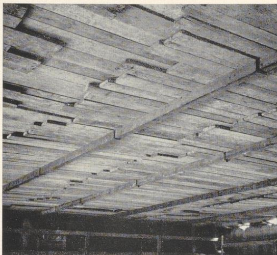
Bild 124. Hängende Innenrüstung ohne jede Stütze, aus Zürich
