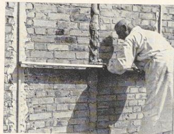
Bild 173. Herausziehen der Mörtelleiste
