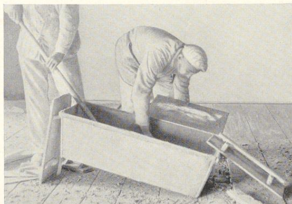
Bild 185. Arbeitsweise in der Pfalz. Der Anmachkasten, ohne Füße, steht direkt auf dem Gerüst
