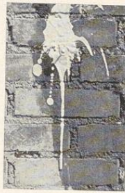
Bild 169. Der Nagel für den Gipspunkt
