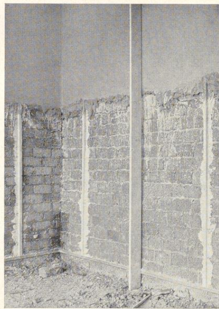
Bild 167. Das Anlegen der Putzleisten an der Wand (Gipsleisten)
