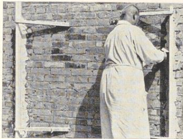
Bild 172. Abstreichen des Mörtels an der Gipsleiste
