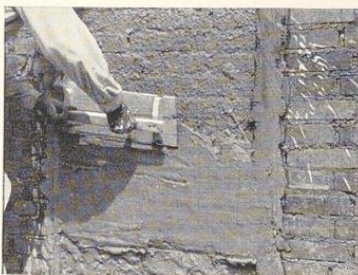
Bild 175. Auftragen des Rauputzes zwischen den Leisten
