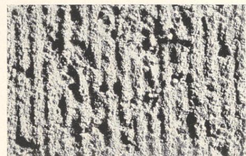
Bild 224. Gekämmter Messelputz
