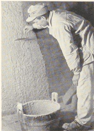
Bild 248. Antragen des Waschputz- mörtels
