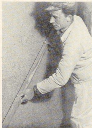
Bild 249. Abziehen des Waschputz- mörtels
