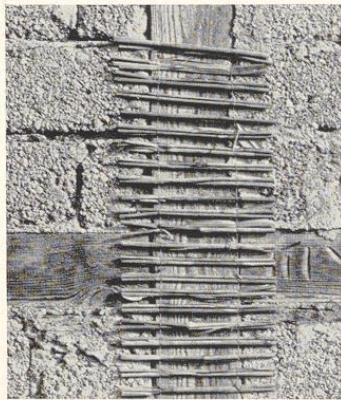
Bild 198. Nicht ganz einwandfreie Holzverwahrung, Putz und Holz ste- hen in Verbindung
