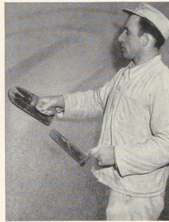
Bild 250. Glätten des Waschputz- mörtels
