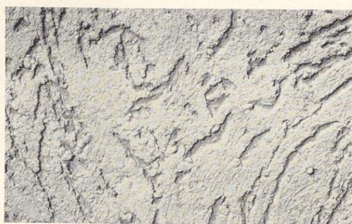
Bild 234. Münchner Rauputz, aus grobkörnigem Material, Auftragstärke 10 mm
