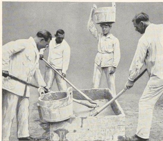
Bild 207. Handmischung des Außenputzmörtels in Württemberg
