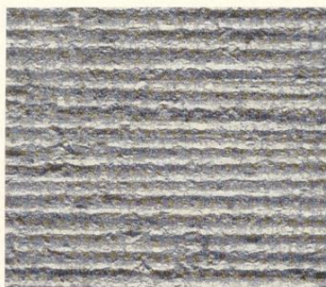
Bild 239. Steinputzbearbeitung mit einfachem breitem Scharrierschlag
