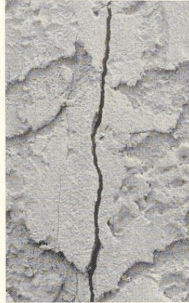
Bild 196–197. Ausgetrockneter, gerissener Holzpfosten einer Fachwerks- wand und Putzriß über einem Holzpfosten ohne Verwahrung
