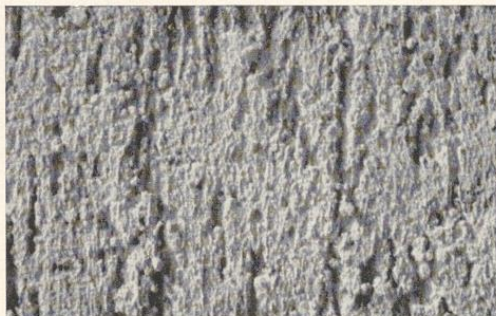
Bild 223. Scheibputz, senkrecht verrieben
