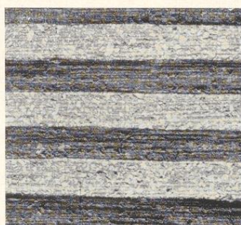
Bild 242. Steinputzbearbeitung mit Doppelschlag von zwei Seiten
