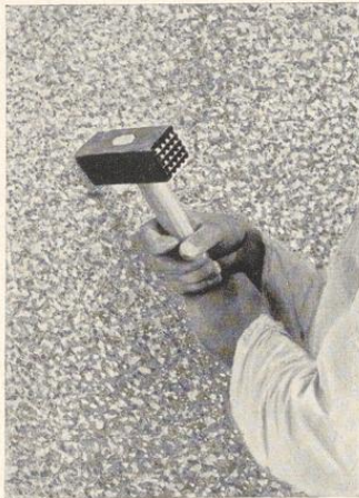
Bild 252. Stocken des Steinputzes
