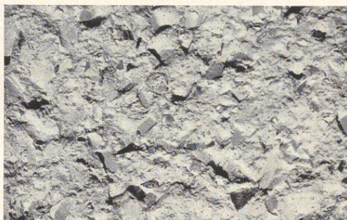
Bild 233. Grober Stockputz mit eckigem Korn
