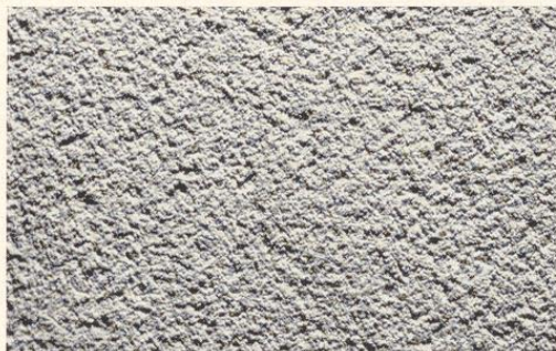
Bild 230. Feingestockter Edelputz. Auftragstärke 5 bis 8 mm
