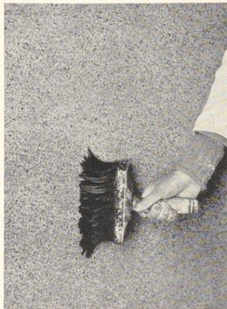
Bild 251. Abtupfen des Waschputzes mit der Bürste
