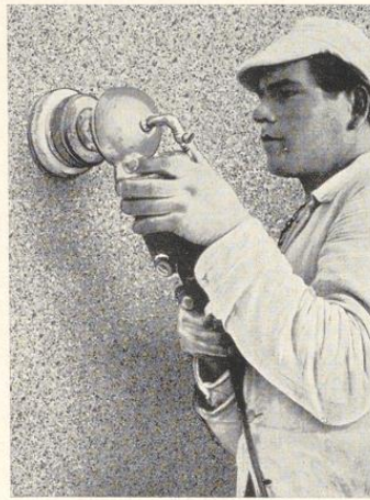
Bild 253. Schleifen des Steinputzes
