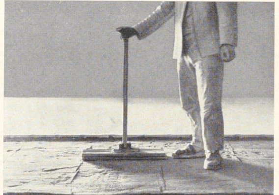
Bild 262. Feststampfen der Sandunterlage nach dem Annässen
