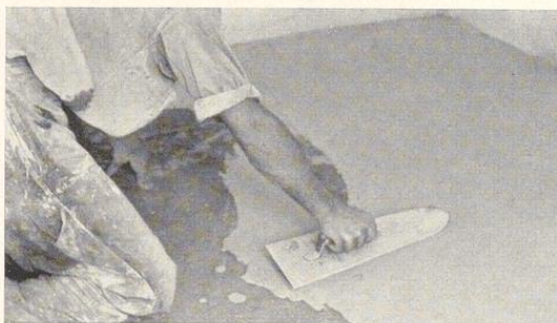
Bild 270. Auftragen und Glätten der reinen Estrichgipsschicht
