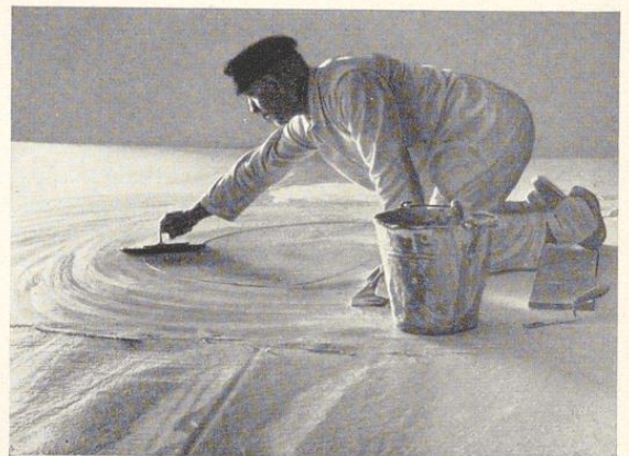
Bild 266. Durchglätten des Gipsestrichs mit der Glättkelle
