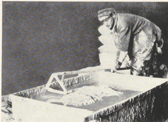
Bild 260. Durchrühren des Estrichgipses mit Mörtelhaken
