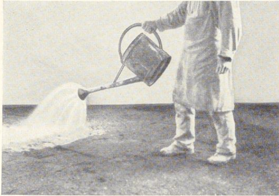
Bild 261. Annässen der Sandunterlage vor dem Verlegen des Gipsestrichs
