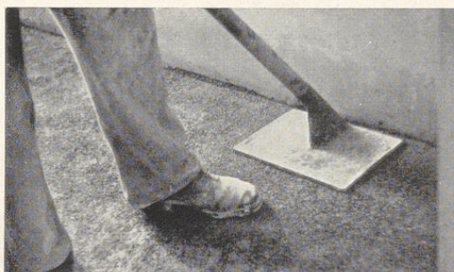
Bild 268. Verdichten der Estrichgips-Sand-Auflage mit der Patsche
