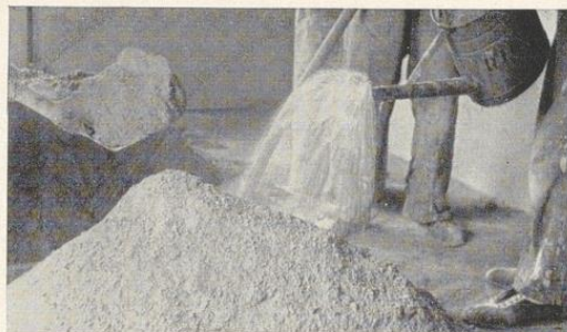
Bild 267. Zubereitung der erdfeuchten Estrichgips-Sand-Mischung
