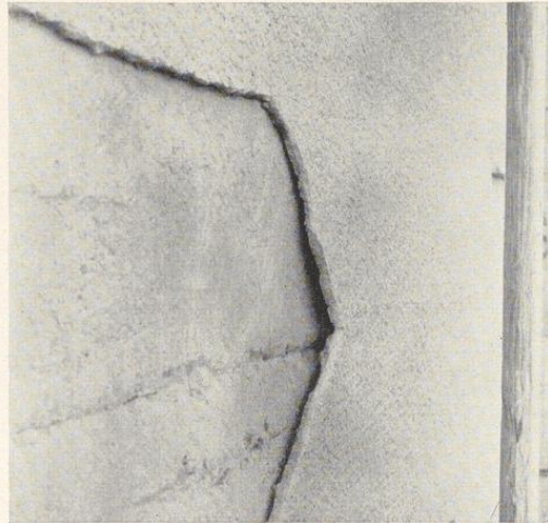
Bild 295. Pressungen und ungenügende Haftfestigkeit führen zur Abtreibung des ganzen Putzes
