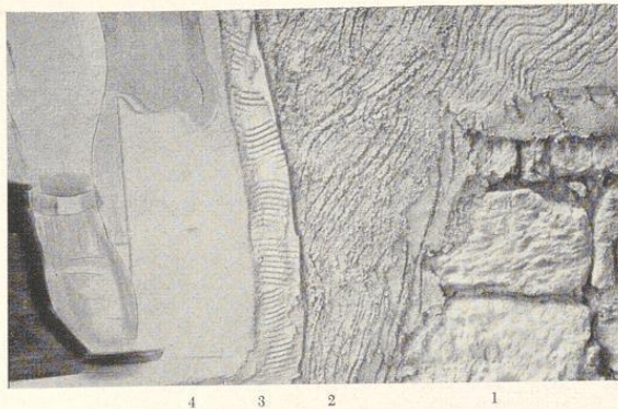
Bild 332. Aufbau der Kalkmörtelschichten: 1 Mauergrund, 2 Rauputz, 3 grober Malgrund, 4 feiner Malgrund
