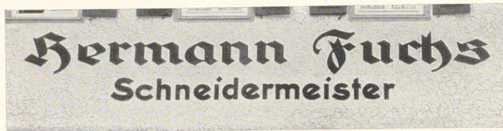
Bild 329. Vertiefte Putzschrift, ausgekratzt, der Schriftgrund gestrichen
