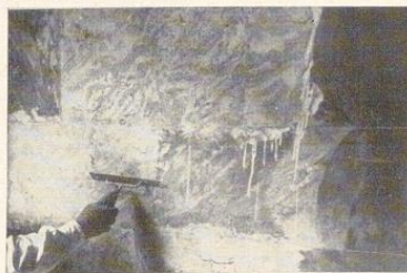
Bild 341. Schneiden des angetragenen Stuckmarmors
