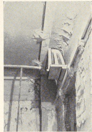
Bild 374. Der Gesimsansschlag an Betondecken
