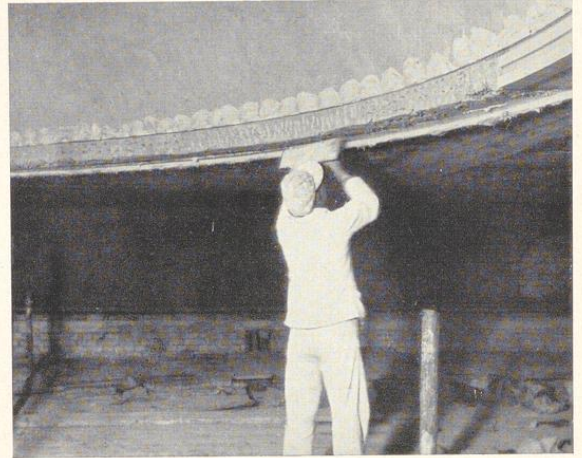
Bild 424. Anlegen des Gipswegs für den Hochdruckanschlag
