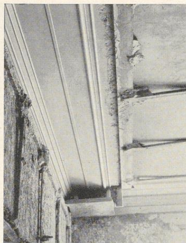
Bild 383. Anschlag für Eck- und Deckengesims
