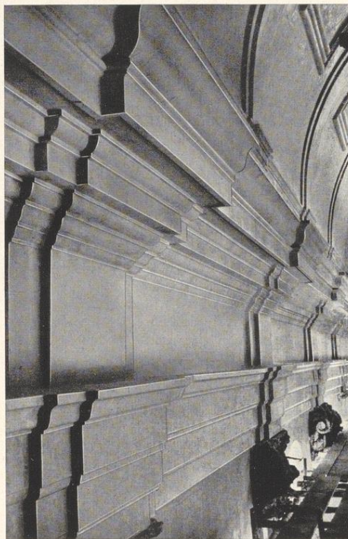
Bild 486. Freihändig zugeschnittene Verkröpfungen. Ausführung Wilhelm Denz, Neckarsulm
