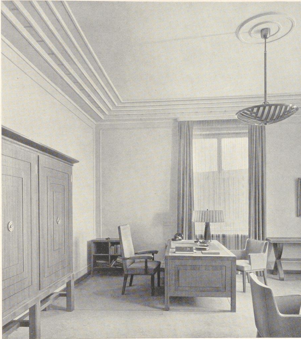
Bild 464. Reich gegliedertes Eckgesims mit eingebauter Entlüftung in einem Verwaltungsgebäude Architekt Fr. A. Breuhaus, Bad Kissingen
