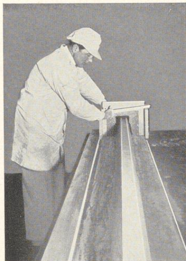
Bild 388. Ausführung eines Gesimszugs (Hohlzug) mit der Tischaablonne
