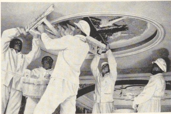
Bild 454. Ovalgesims für indirekte Beleuchtung mit dem Ovalkreuz gezogen
