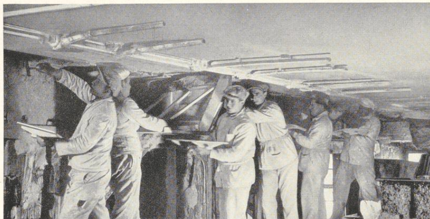
Bild 379. Ziehen eines großen Eckgesimses von 20 m Länge
