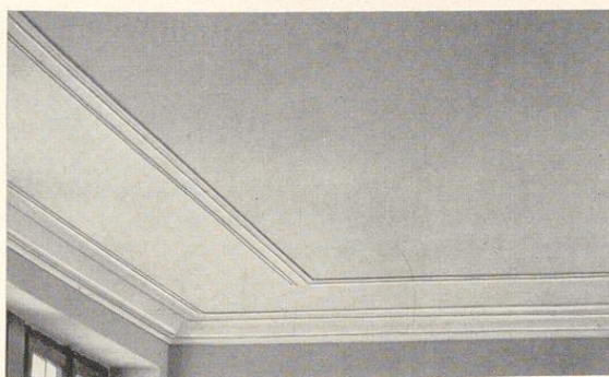
Bild 385 und 386. Fertig gezogene, stark profilierte Eck- und Deckengesimse
