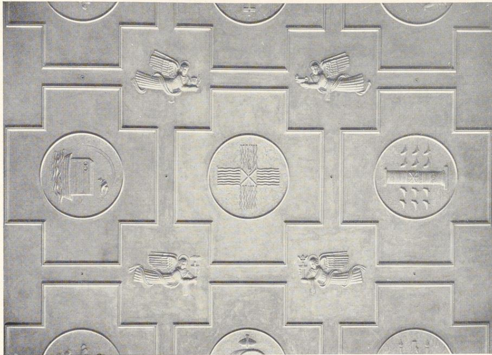
Bild 507. Stuckdecke mit freihändiger Antragarbeit in einem Gedächtnishaus in Wien. Architekt Clemens Holzmeister, Wien. Bildhauerin Gudrun Baudisch
