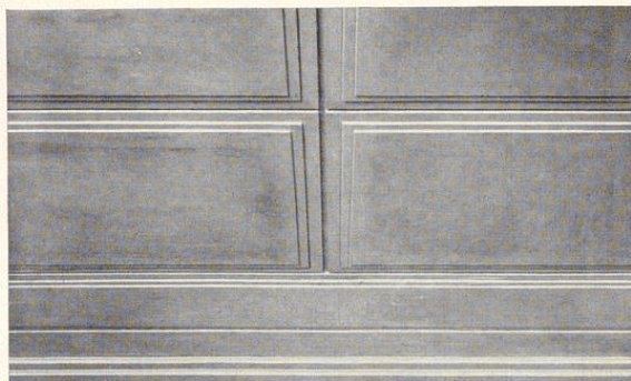
Bild 512. Kassettendecke mit fertigem Kreuzzug
