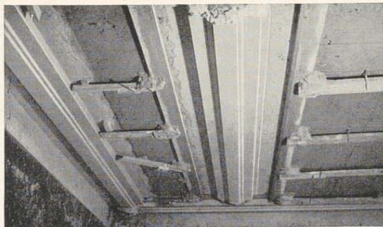
Bild 496. Fertiger Gesimszug über den Leichtbauplatten
