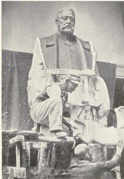
Bild 629. Die Anfertigung der Stückform über das Tonmodell zur Herstellung einer provisorischen Statue
