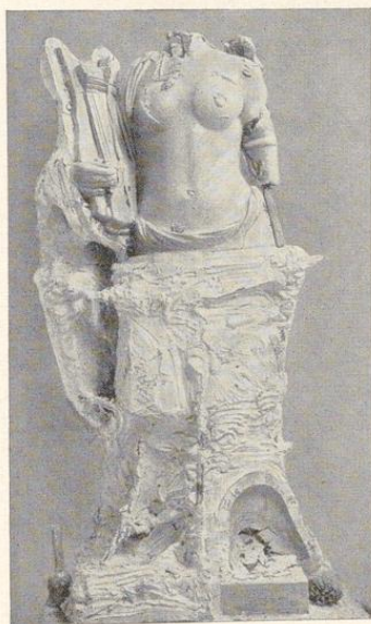
Bild 541. Abnehmen der einzelnen Formschalenteile
