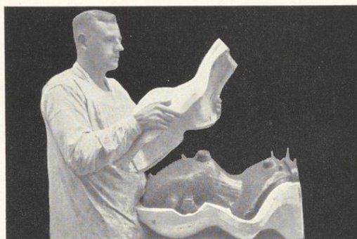
Bild 591. Abnehmen der Vorderschale nach Ausführung des Leimgusses
