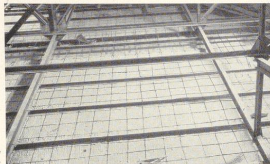
Bild 730. Rabitzdecke ohne Abhänger, die eisernen Träger wurden für diesen Zweck besonders angelegt
