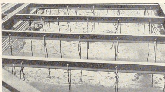
Bild 723. Abhängerbefestigung an durchbohrten eisernen Trägern
