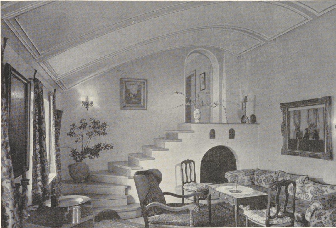
Bild 745. Gewölbte Rabitzdecke mit profilierter Felderteilung im Restaurant Schön Am Obelisk in München. Architekt Eduard von der Lippe, München. Ausführung Heinrich Voll, München
