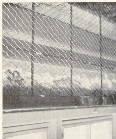
Bild 751. Rabitzkonstruktion für einen Rolladenkasten
