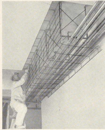
Bild 758. Rabitzummantelung von Rohrleitungen mit Baustahlmatten
