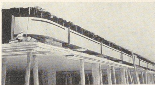
Bild 765. In Rabitzdecke eingebauter Entlüftungskanal. Universum-Filmtheater, Stuttgart
