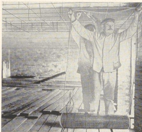
Bild 793. Aufziehen und Anheften des Rabitzgewebes
