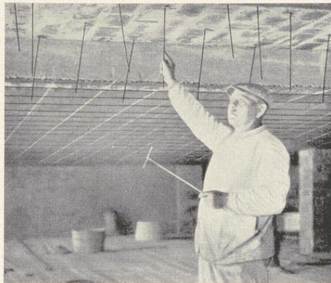
Bild 791. Einhängen der Abhänger in die Hohlkörperdecke. Das Schließen der Löcher erfolgt mit Zementmörtel
