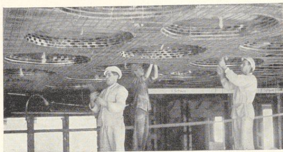
Bild 808. Rabitzdecke mit runden Vertiefungen für Beleuchtungskörper. Ausführung Stukkateurmeister E. Schwarz, Stuttgart-Hedelfingen
