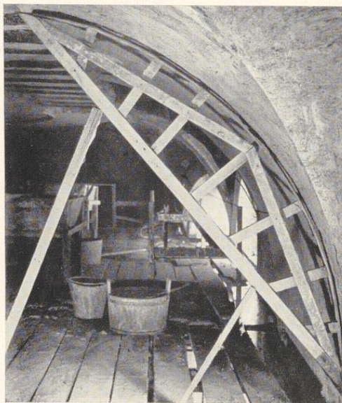
Bild 847. Auf Kämpferlatten eingesetzter Lehrbogen am Spitzbogen-Kreuzgewölbe
