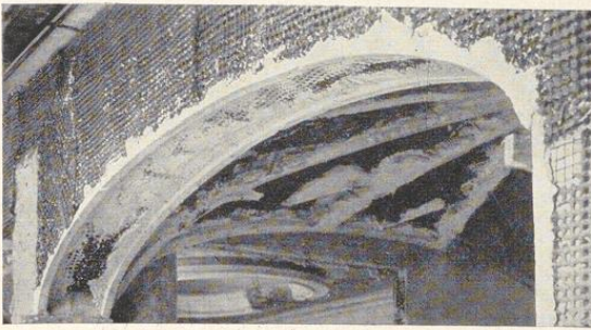
Bild 864. Flache Gipslehen an einem Gurtbogen
