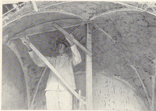
Bild 986. Grundieren der Gewölbeffläche einer Stutzkuppel mit dem drehbaren Flügel
