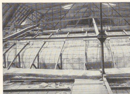
Bild 863. Abhängung einer Rundkuppel an besonders dafür geschaffener Formeisenkonstruktion. Im Vordergrund Laufstege zum Begehen des Gewölbes
