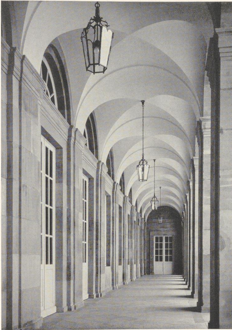
Bild 830. Aufgelöstes Tonnengewölbe in Rabitzausführung vom Wiederaufbau des Schlosses in Koblenz. Entwurf Staatl. Hochbauamt Koblenz. Ausführung Kunstwerkstätten Professor Lauer mann, Düsseldorf-Grafenberg
