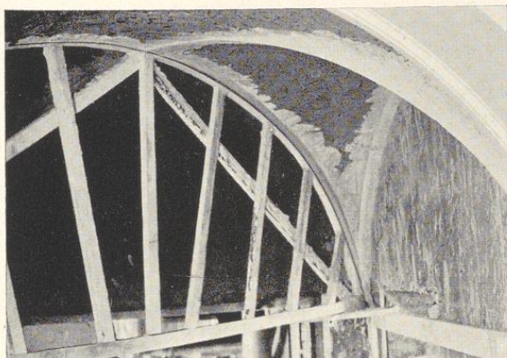
Bild 933. Anlegen der Gipslehren mit Hilfe des Lehrbogens
