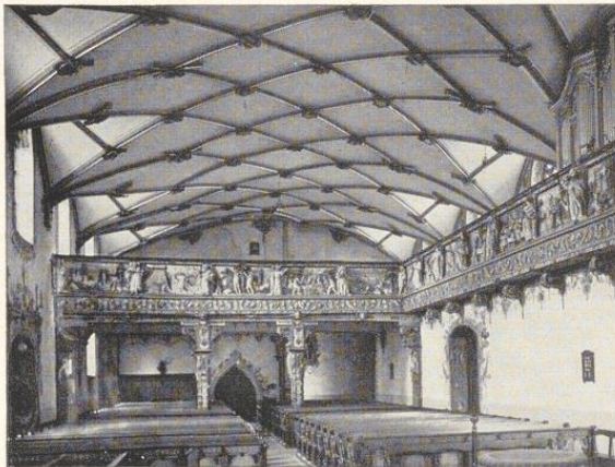
Bild 885. Netzgewölbe (Flachbogentonne) mit profilierten Diagonalrippen. Evangelische Kirche, Freudenstadt (Württ.)
