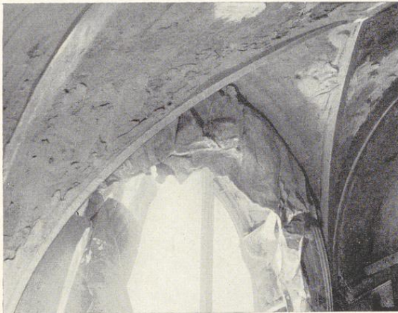
Bild 916. Nach dem Lehrbogen angelegte Gipslehren zum Ausputzen der Stichkappe
