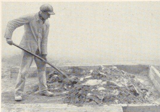
Bild 33. Mörtelbereitung im Rheinland auf einem nach 3 Seiten geschlossenen Dielenbelag
