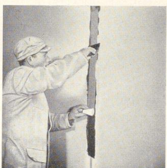
Bild 62. Aufspachteln des Nesselstreifens
