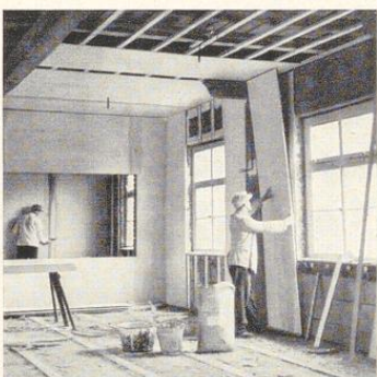
Bild 61. Ansetzen der Platte an der Wand
