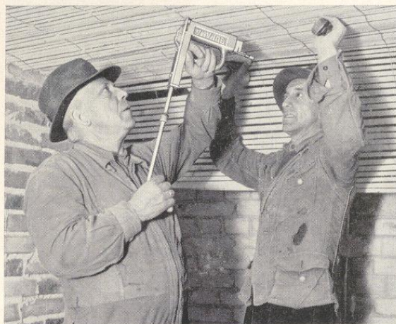
Bild 102. Befestigung von Holzstabgewebe mit dem Bukama-Rohrhefter
