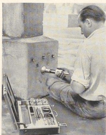
Bild 101. Einschießen der Bolzen mit dem Rapidhammer
