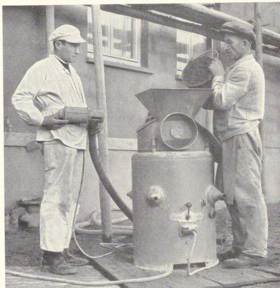
Bild 98. Elektrische Mörtelmisch- und Verputzmaschine von Dr. Posch
