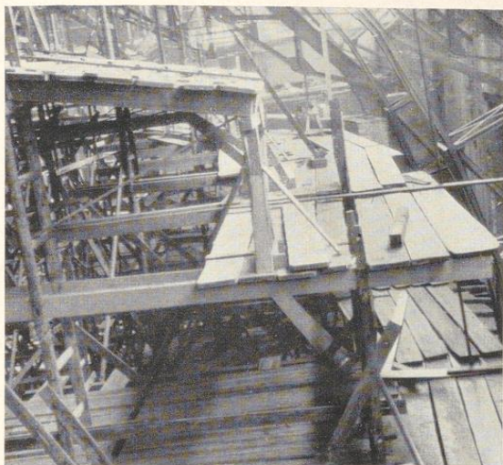
Bild 119. Abgesetztes Leitergerüst (Stufengerüst) zur Einrüstung eines Gewölbes. Berlin
