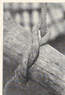
Bild 139. Der Latz zum Hochziehen der Stangen
