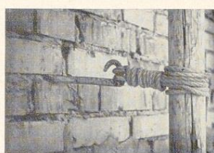
Bild 142. Binden der senkrechten Stellstangen an den Mauer- oder Steinhaken mittels Achterbund
