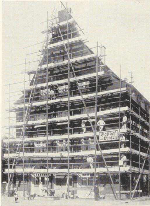
Bild 126. Leichtes Doppelstangengerüst mit Verstrebung, die Eckstangen etwa 1 m vom Eck entfernt. Baden
