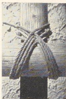
Bild 137. Binden der Streich- und Sicherheitsstangen mittels Kreuzbund
