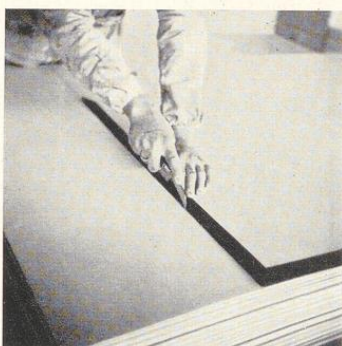
Bild 58. Durchschneiden des Kartons
