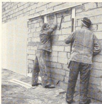
Bild 56. Ausfluchten des Streifenrostes
