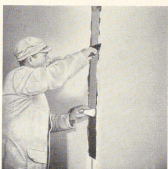
Bild 62. Aufspachteln des Nesselstreifens
