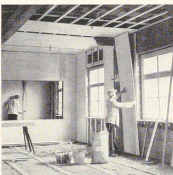
Bild 61. Ansetzen der Platte an der Wand
