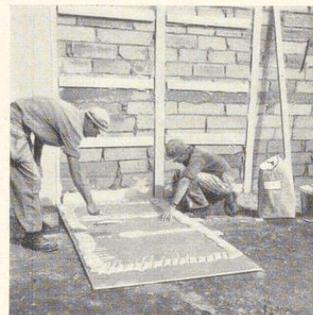
Bild 57. Auftragen von Leimfix
