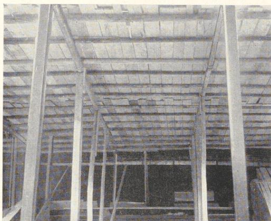
Bild 112. Innen- rüstung mit Sattel- und Streichstangen und einem Gerüstboden aus Brettern
