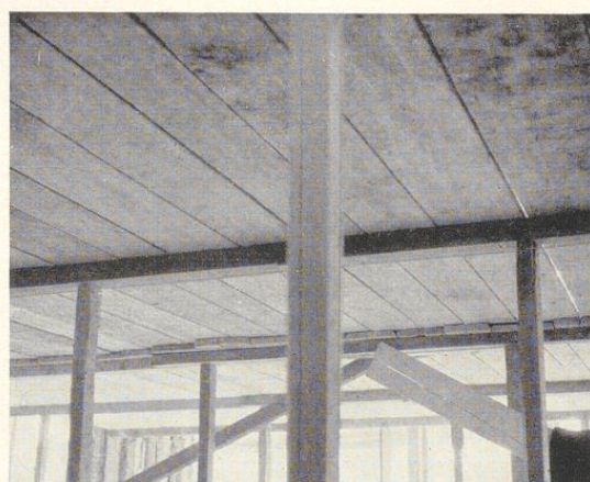
Bild 113. Innen- rüstung aus Zürich mittels Kantholz und Dielen ohne Strickbindung
