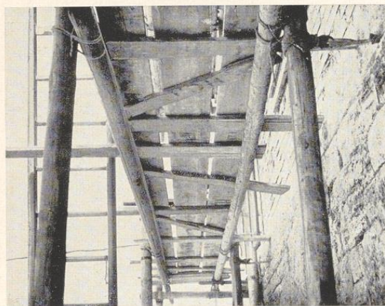
Bild 125. Leichtes Doppelstangengerüst, süddeutsche Art, Verankerung an der Wand und Verstrebung des Gerüstbodens mittels Spangen
