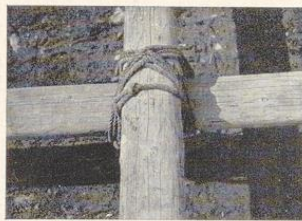
Bild 141. Binden nebeneinanderliegender, sich kreuzender Stangen mittels Kreuzbund
