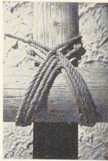
Bild 137. Binden der Streich- und Sicherheitsstangen mittels Kreuzbund
