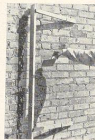
Bild 171. Anwerfen der Gipsleiste
