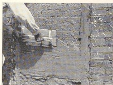
Bild 175. Auftragen des Rauputzes zwischen den Leisten
