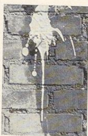
Bild 169. Der Nagel für den Gipspunkt
