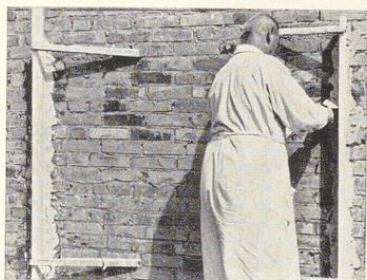
Bild 172. Abstreichen des Mörtels an der Gipsleiste
