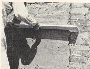
Bild 176. Abziehen des Rauputzes mit der Latte
