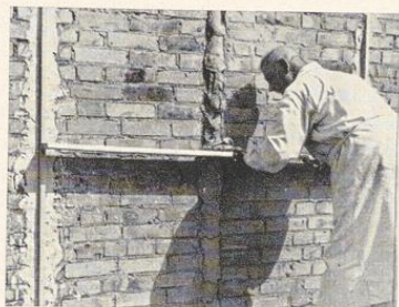
Bild 173. Herausziehen der Mörtelleiste
