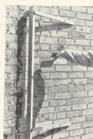
Bild 171. Anwerfen der Gipsleiste
