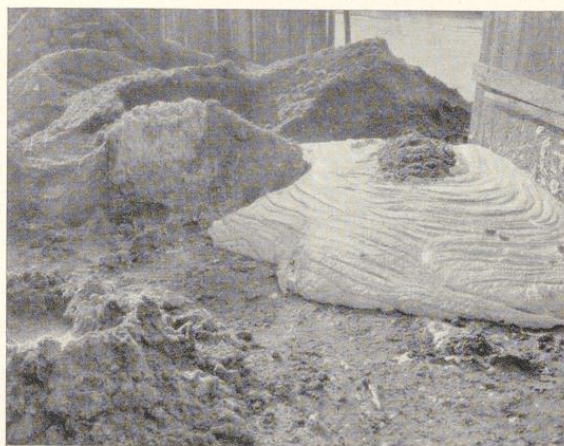
Bild 180. Kalkmörtelbereitung in Köln
