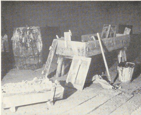
Bild 183. Arbeitsweise in Hamburg. Die Mörtelbereitung erfolgt auf dem Gerüst. Zuerst werden Kalk und Sand gemischt und dann der Gipskalkmörtel bereitet. Im Eimer befindet sich Leim, der zur Verzögerung der Bindezeit des Mörtels verwendet wird
