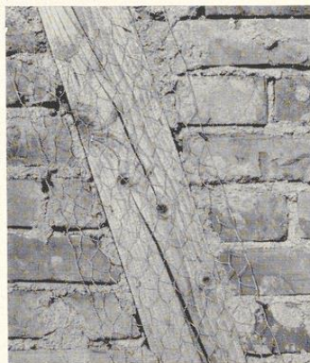
Bild 199. Falsche Holzverwahrung, Putz und Holz stehen in Verbindung
