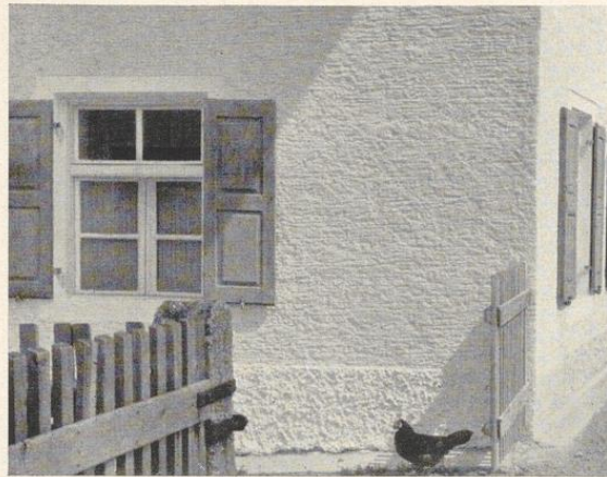
Bild 211. Einfacher Kalkputz, waagrecht geschleibt, an einem Bauernhaus
