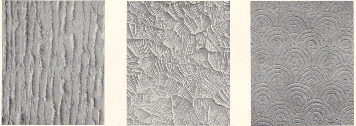
Bild 218–220. Putzbehandlung unruhig und schablonenhaft, wie sie nicht ausgeführt werden soll
