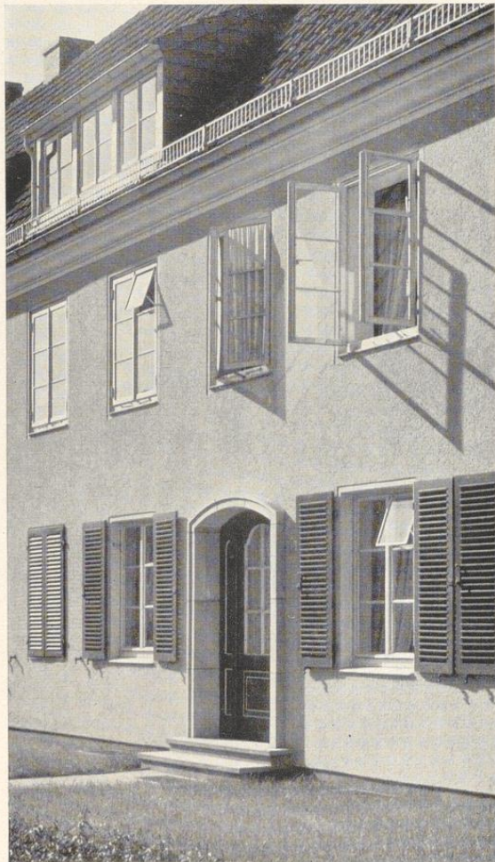
Bild 236. Eingang zum Postgebäude in Ortenburg. Arch. Bayr. Postverwaltung. Grobkörniger Kratzputz in guter Übereinstimmung mit Gittertüre und Plastik
