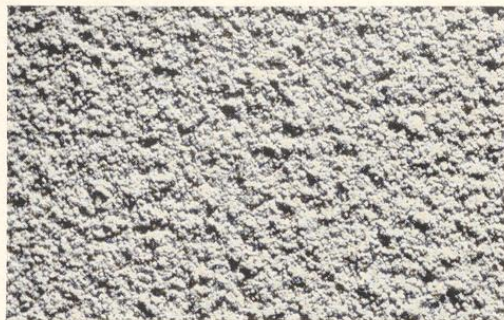
Bild 228. Besenwurf aus Edelputzmaterial (Spezialsorte)
