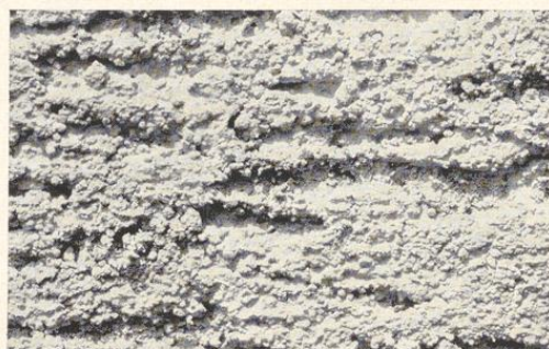
Bild 235. Münchner Rauputz aus grobkörnigem Material, waagrecht verschiebt
