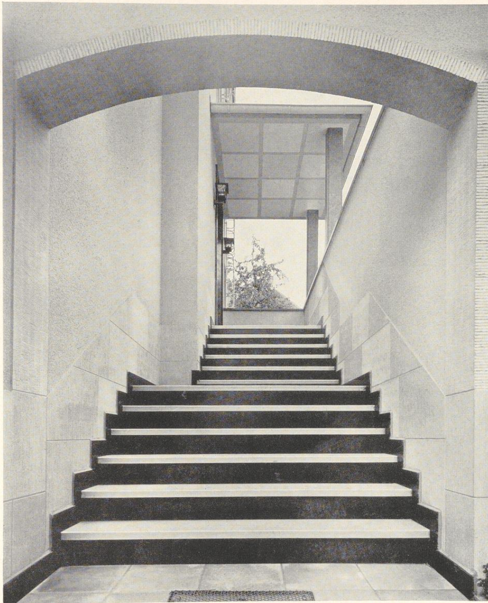
Bild 244. Treppenaufgang eines Wohnhauses. Wände in Edel- und Steinputz ausgeführt. Treppenstufen Marmor. Ausführung Willh. Odenthal, Unterbach/Düsseldorf
