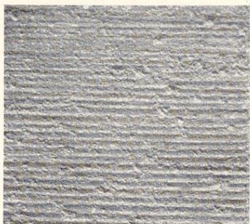
Bild 238. Steinputzbearbeitung mit einfachem schmalen Scharrierschlag
