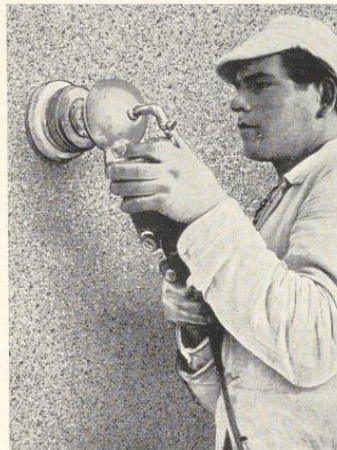
Bild 253. Schleifen des Steinputzes
