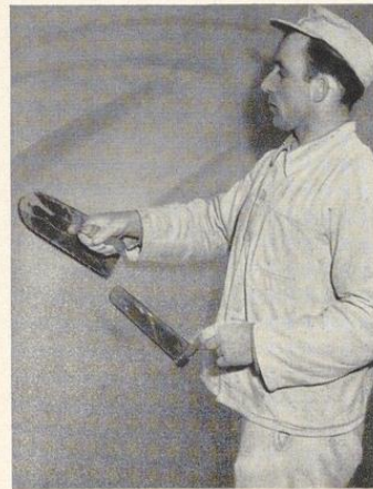
Bild 250. Glätten des Waschputz- mörtels
