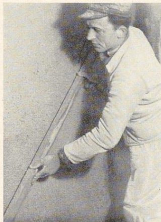
Bild 249. Abziehen des Waschputz- mörtels
