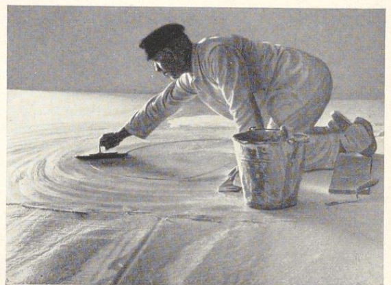
Bild 266. Durchglätten des Gipsestrichs mit der Glättkelle
