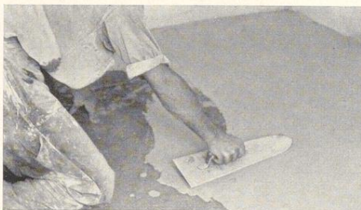
Bild 270. Auftragen und Glätten der reinen Estrichgipsschicht
