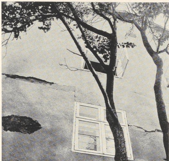
Bild 272. Putz auf chlormagnesiumhaltigen Bauplatten. Die Einwirkung von Feuchtigkeit hat zu diesen starken Treiberscheinungen geführt
