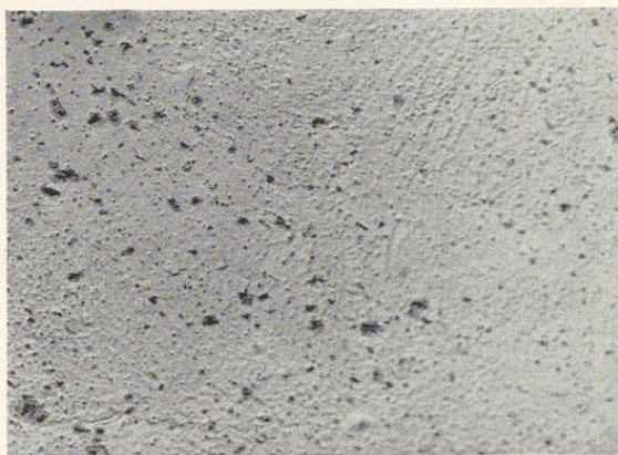
Bild 283. Treiberscheinung im Putz, sogenannte Schrotschüsse, von Kalkgrießen (Kalkmännchen) herrührend
