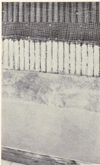
Bild 303. Isolierung einer feuchten Wand mit Falzbautafeln. Zur Erzielung einer guten Putzhaftung werden die Falzbautafeln mit Rabitzgewebe überspannt
