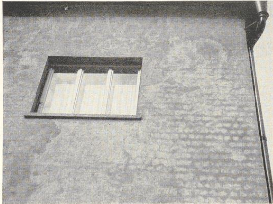
Bild 289. Durchschlagen der Fugen infolge zu schwachen Putzes
