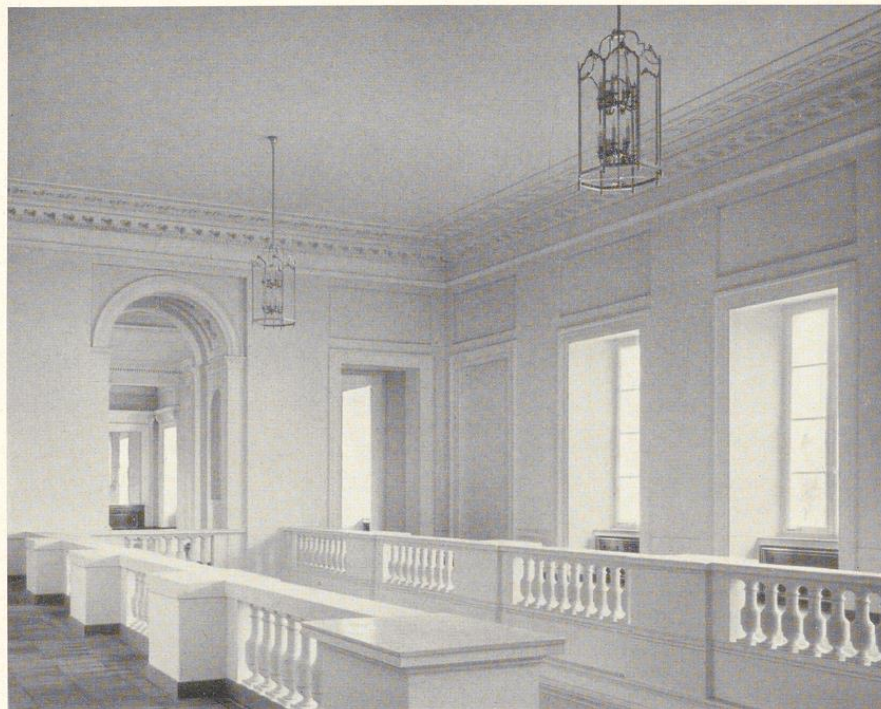
Bild 311. Treppenhalle im Schloß in Koblenz. Brüstung mit Balustern aus weißem Zement. Ausführung Kunstgewerbliche Werkstätten Prof. Lauer mann, Düsseldorf-Grafenberg
