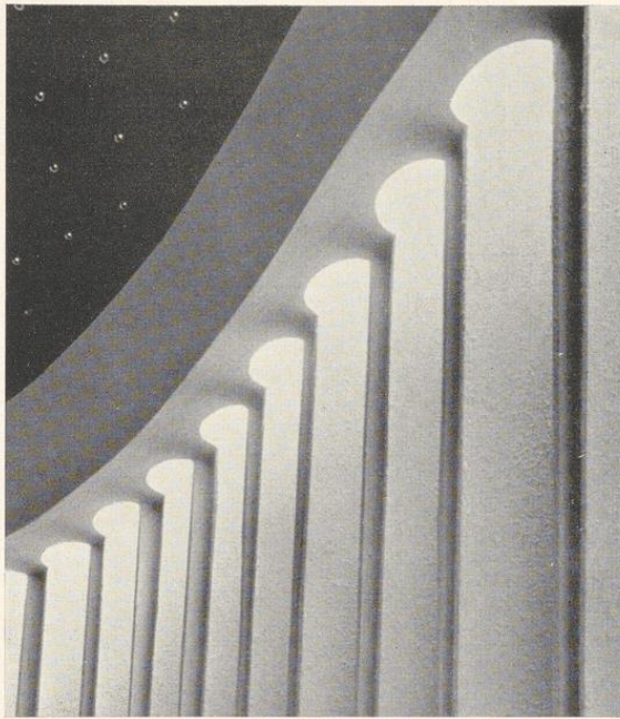
Bild 316. Einzelheit zu Bild 315. Hohlsäulen in Stuck für indirekte Beleuchtung und als Abschluß eines Sitzplatzes
