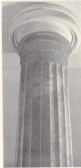
Bild 345. Oberer Teil der fertigen Marmorsäule
