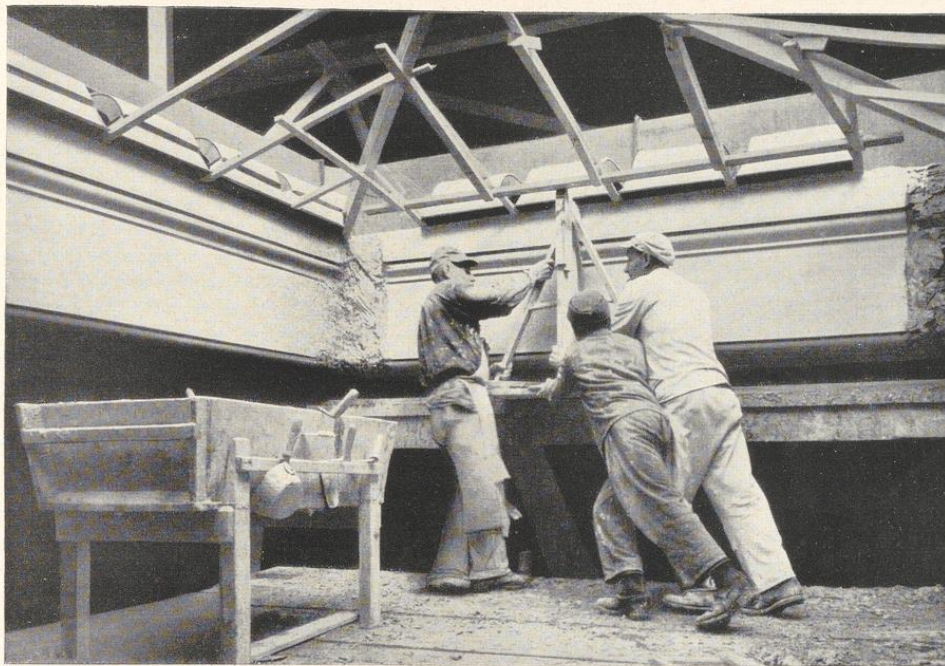
Bild 348. Großer Gesimszug in einer Oberlichtöffnung. Ausführung Stuckgeschäft F. Bender, München
